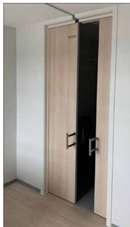
Sykehjem: 2-fløyet skyvedør til bad m/uttak i karm for takheis
